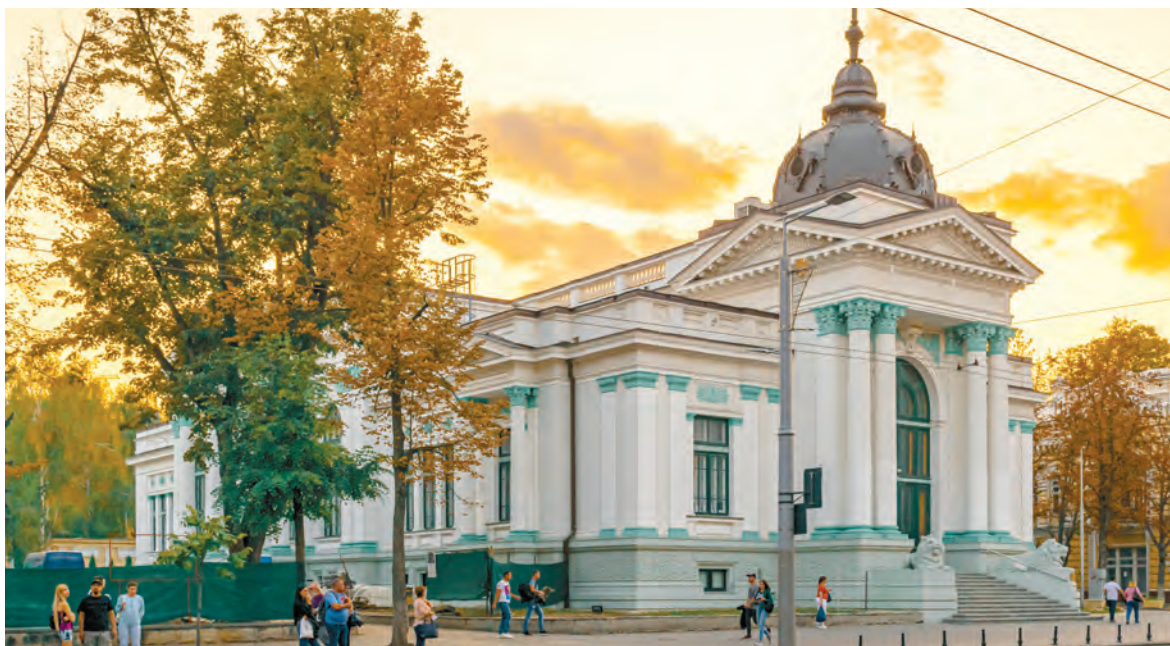
Clădirea Sălii cu Orgă din Chișinău
