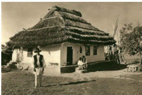
Fig. 1. Casă țărănească cu tindă și o cameră
