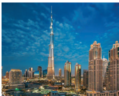
Fig. 10. Clădirea Burj-Khalifa, 828 m, 2009 (Dubai, Emiratele Arabe Unite)
