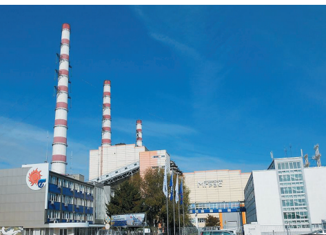
Fig. 3.46. Centrala Termoelectrică Moldovenească de la Dnestrovsc
