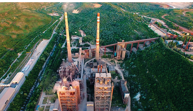
Fig. 3.56. Fabrica de Ciment din or. Rezină
