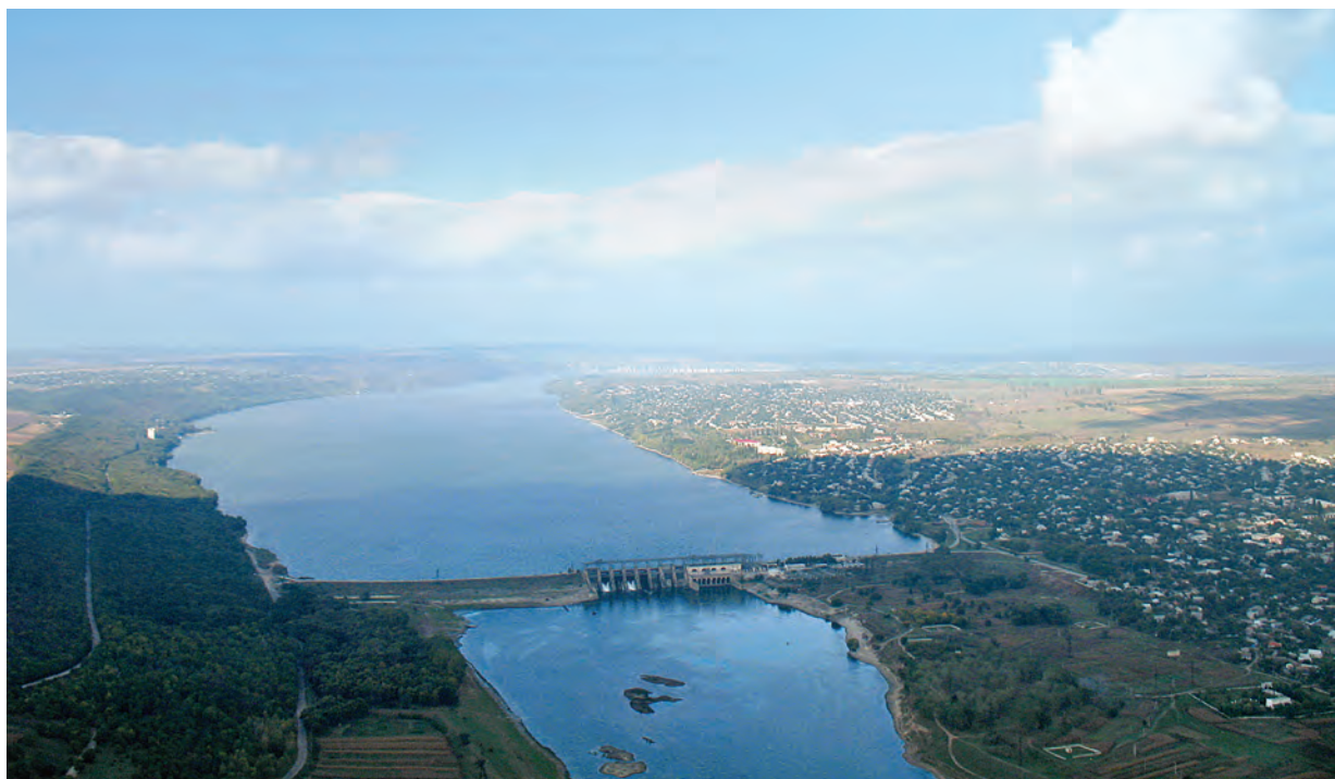
Fig. 2.34. Lacul de acumulare Dubăsari pe fluviul Nistru în sectorul sudic (în prim-plan este barajul și centrala hidroelectrică)
