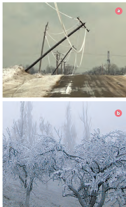
Fig. 2.19. Plante și rețele electrice afectate de chiciură (a) și polei (b)
