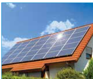
Источник энергии — солнечные панели
