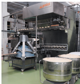
Рис. 3.14. Цех хлебокомбината «Франзелуца» в мун. Кишинёв
