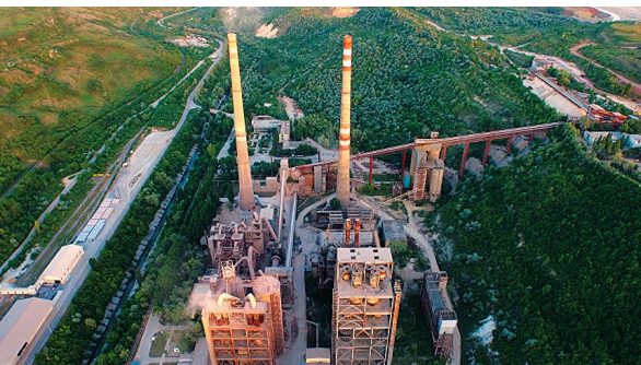
Рис. 3.56. Цементный завод в г. Резина
