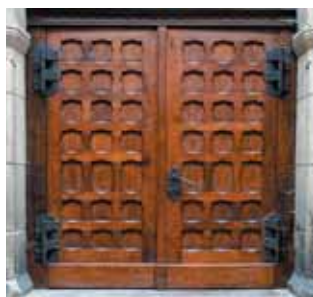
1 Un portail – la grande porte d'une église.
