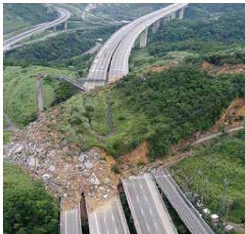
Fig. 31. Prăbușire de versant
